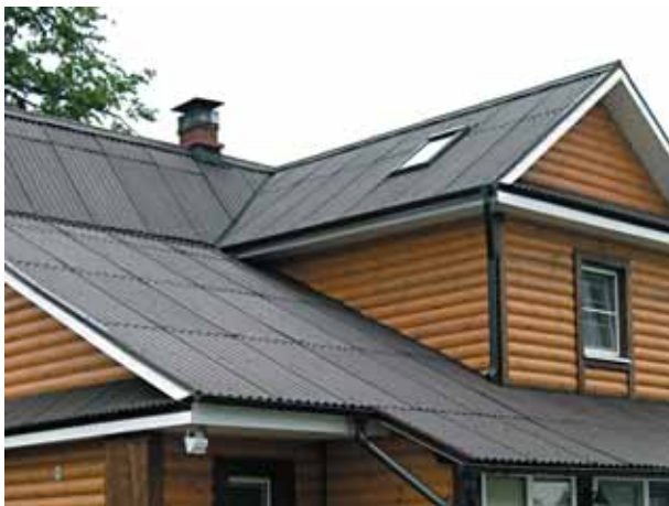
керамопласт, имитирующий шифер и черепицу
