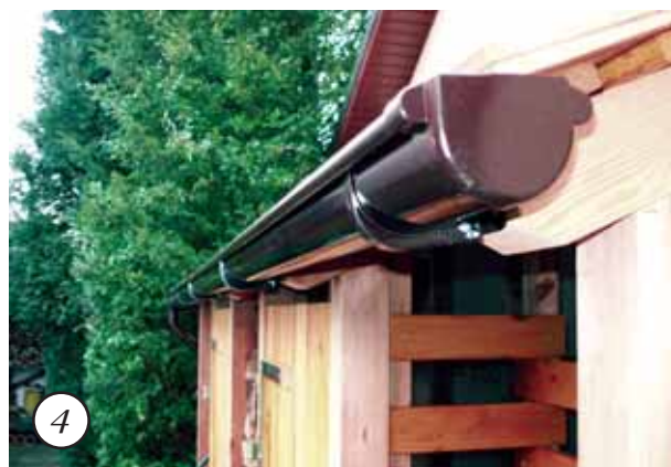
Концевой элемент просто вдвигается в желоб
