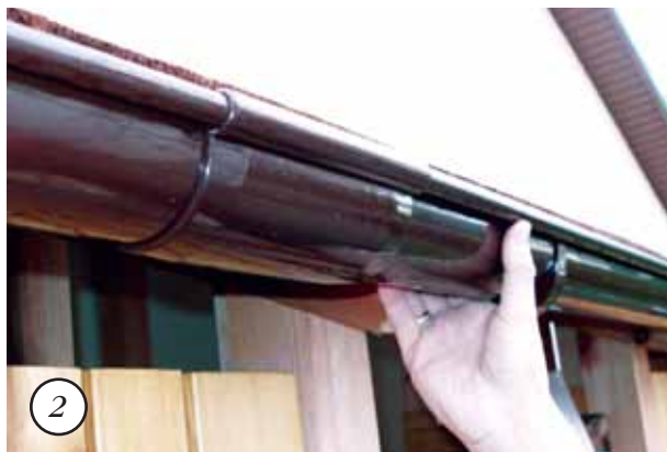
Стыковка двух частей желоба водостока осуществляется соединительной чашкой
