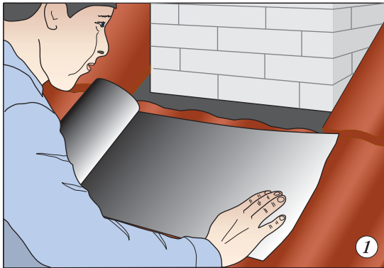
Отмерить и отрезать свинцовую полосу
