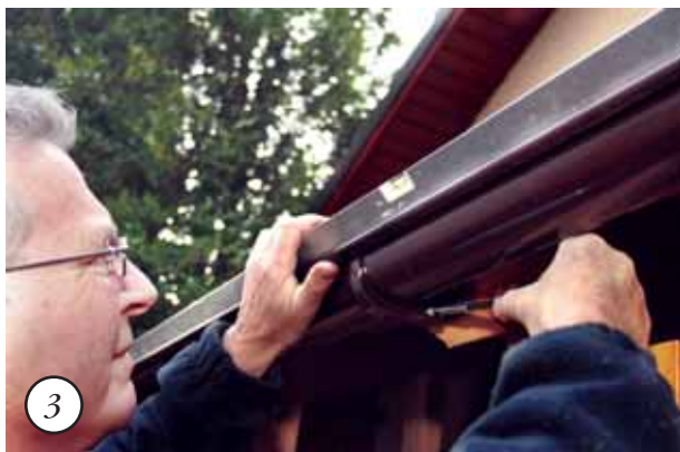
При необходимости кронштейны могут быть подрегулированы
