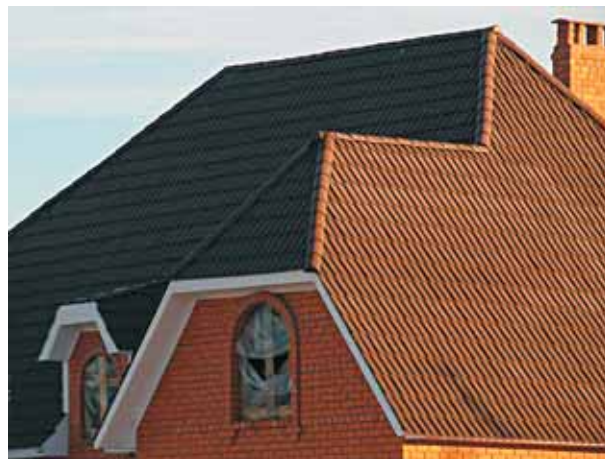
керамопласт, имитирующий шифер и черепицу
