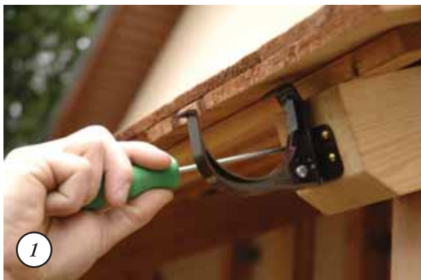
Кронштейны монтируются с интервалом, предусмотренным фирмой-изготовителем водоотвода. Кронштейны устанавливаются так, чтобы сливной желоб можно было отрегулировать по уклону
